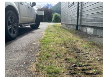
Flatt terreng inn mot bygning
