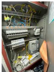
Sikringsskap under ombygging
