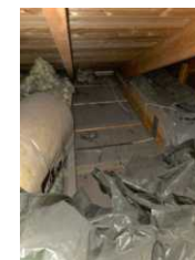
Mangler isolasjon over del på stue som er tilbygget
