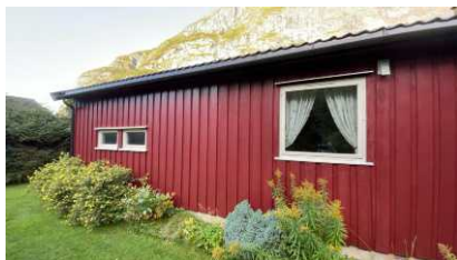
Vindu på soverom fra 1984
