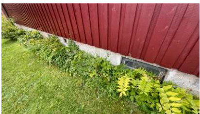
Kjellervindu med koblede glass
