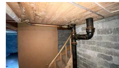
Synlige avløpsrør i kjeller
