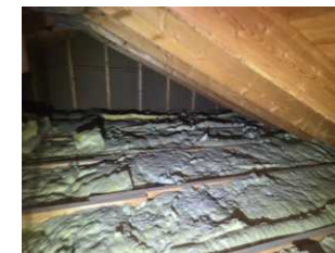
Mangler isolasjon over del på stue som er tilbygget
