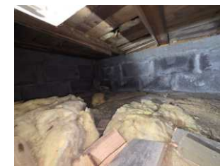
Det er synlig åpen isolasjon i bjelkelag enkelte steder
