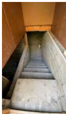
Trapp sett fra inngang til kjeller ved garasje
