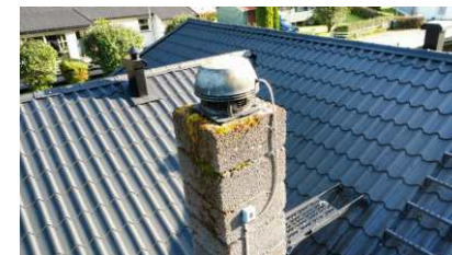
Oversikt pipe med avtrekksvifte som er koblet fra ifølge selger
