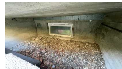
Oversikt grunnmur under repo til hovedtrapp
