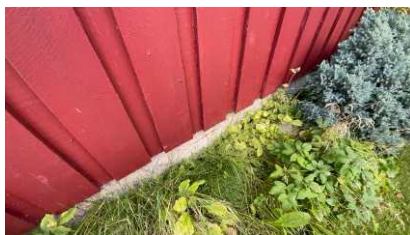
Noe slitasje på nedre del av kledning fra byggeår
