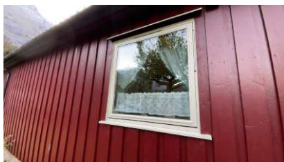
Vindu på kjøkken fra 1984
