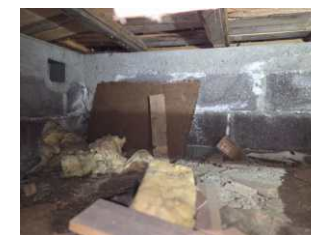
Det er synlig åpen isolasjon i bjelkelag enkelte steder
