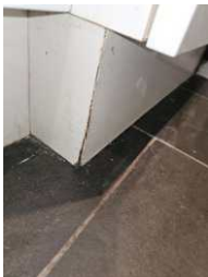
Skade på sokkelfront, trolig etter vannsøl
