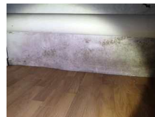
Fuktmåling i utlektet vegg på kjellerstue
