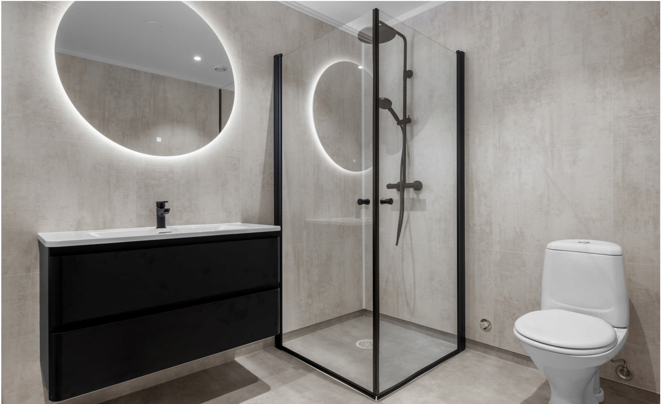
Badet ble totalrenovert med ny oppbygging av vegger og gulv.
