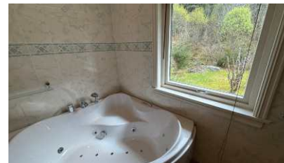
Vinduet er plassert i våtsonen til badekaret
