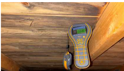
Ingen tegn til forhøyede fuktverdier ved fuktmålinger på befaringsdagen
