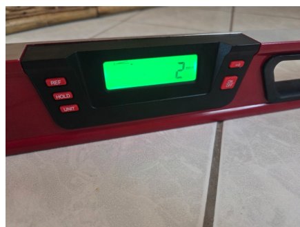
Måling av fall på gulv.
