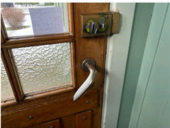
Slitt låskasse på hoveddør
