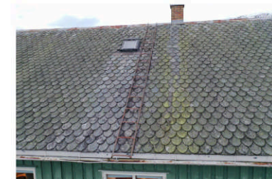
Løst montert takstige
