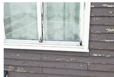
Råteskadet vindu
